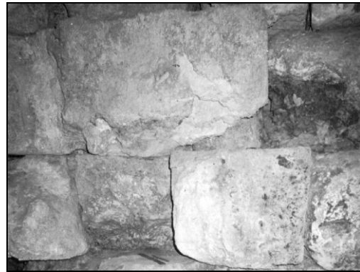
Figure Σφάλμα! Άγνωστη παράμετρος αλλαγής.. All the Tombs are constructed with travertine
